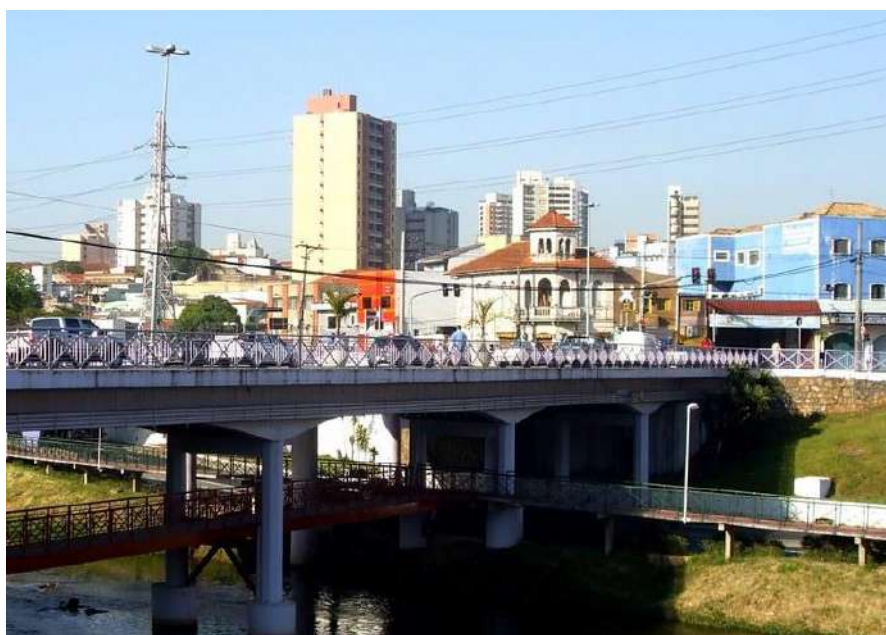
Figura 68 – Ponte da Rua XV de Novembro
