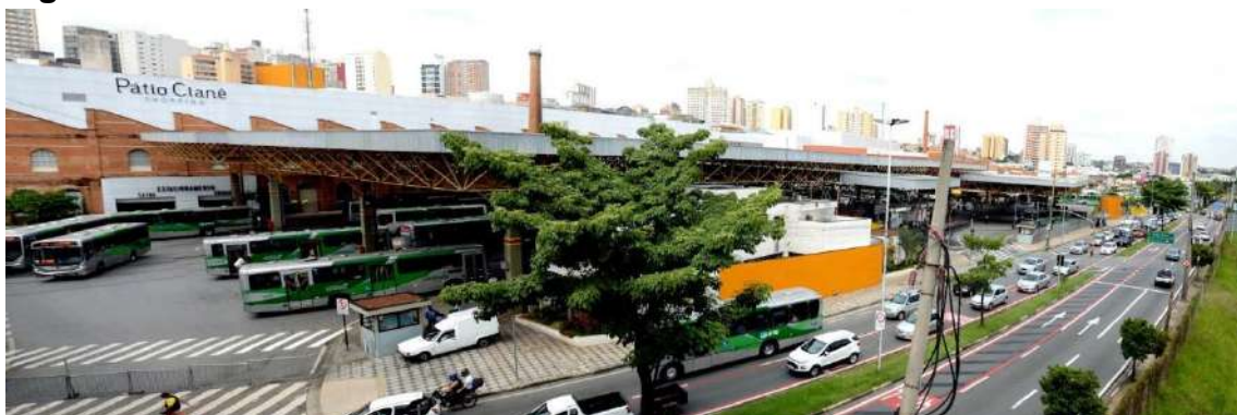
Figura 11 - Terminal de Ônibus Santo Antônio
