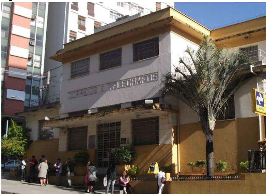
Figura 55 – Prédio dos Correios
